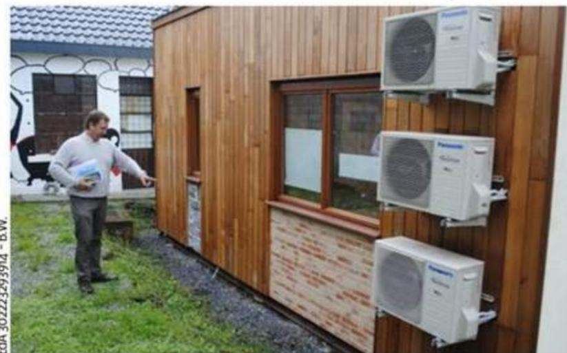
**Murs en paille, pompes à chaleur et ventilation mécanique contrôlée : le Cube réunit plusieurs techniques écologiquement plus soutenables.**
